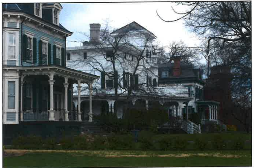
S. Hamilton Street Row (87, 85, 83, 81 S. Hamilton Street)
